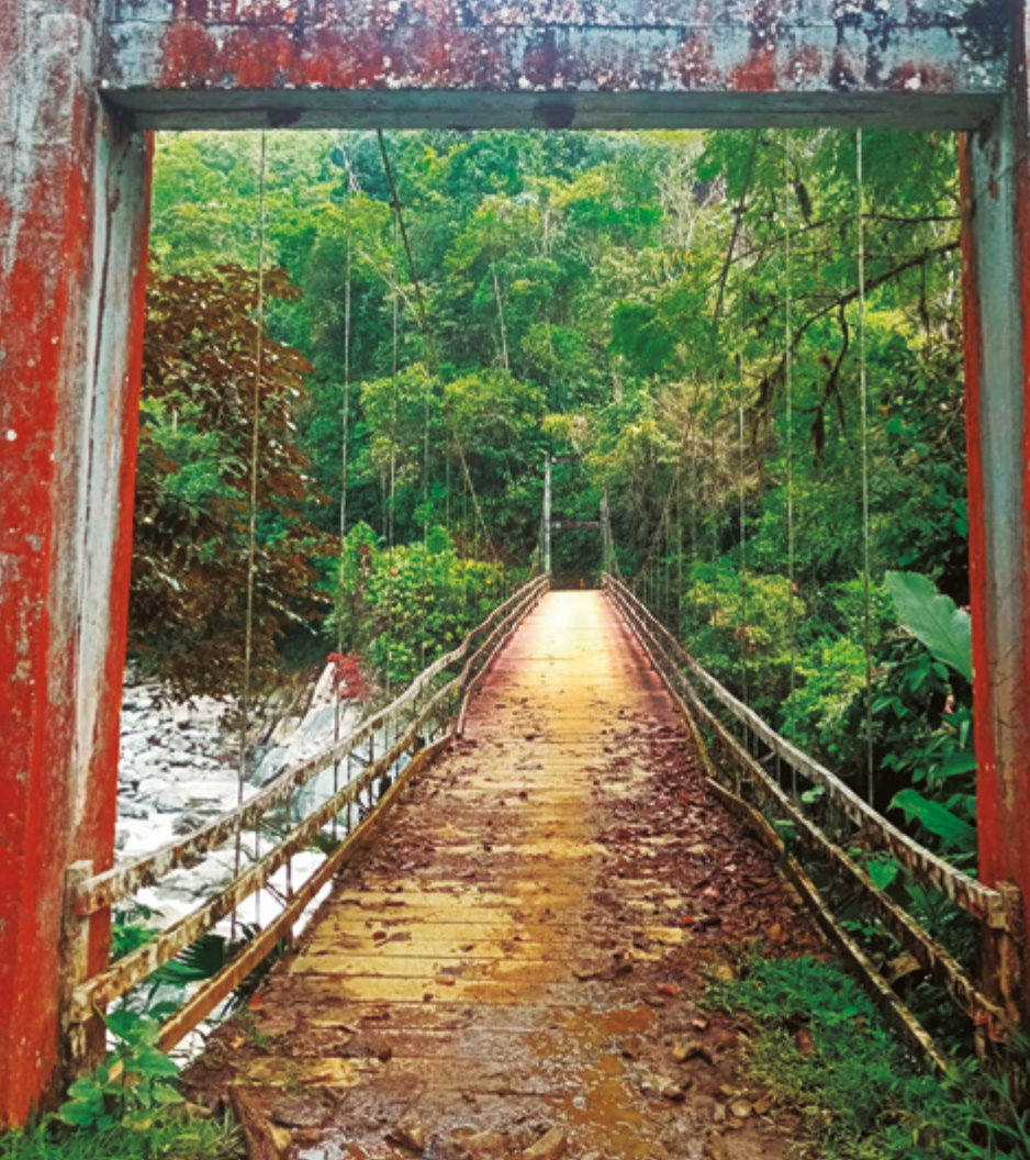
Puente sobre el río Santo Domingo, sector los encuentros San Francisco, Antioquia, febrero 2023. Foto: Hernán Pineda.
